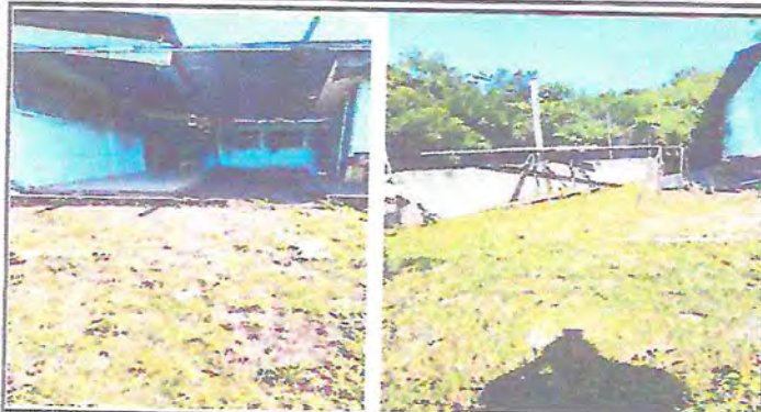
Foto1: LOSA DE PATIO
