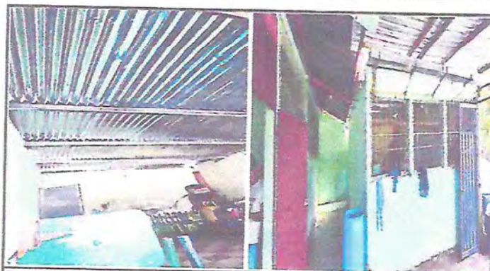
Foto 4: TECHO DE COCINA
