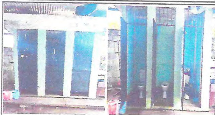
Foto 1: REMOZAMIENTO DE BAÑOS
